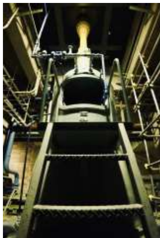
汚水ポンプ施設
