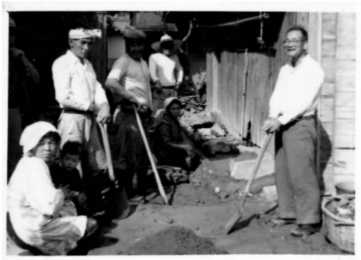
사진 2 하수구 공사의 한 장면
