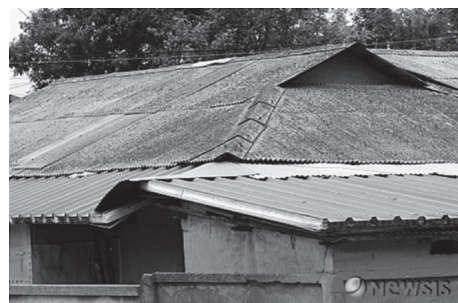
資料4：スレート屋根（『ニュース』2011年5月25日「スレート屋根建築物」記事より転載）
