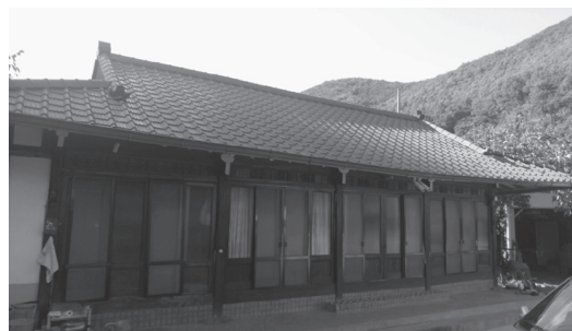
写真7 : ガラスの引き戸を利用した板の間の内部空間化(慶尚北道新道1里 2017年10月撮影)
