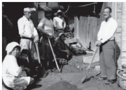
写真2 下水溝工事の一場面
