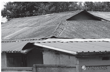
资料4:石棉瓦屋顶(《NEWSIS》,2011年5月25日, 引自报道“石棉瓦建筑物”)。
