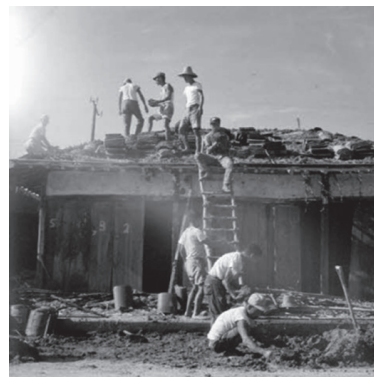
資料3：藁葺き屋根の改良作業（全羅北道 チヨルラブクト 扶安1972年）国家記録院（ http://www.archives.go.kr ）より転載
