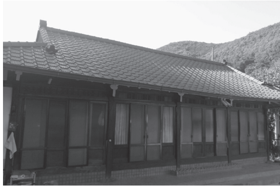
照片7：利用玻璃推拉门将外通廊空间作内部化处理（庆尚北道新道1里，摄于2017年10月）
