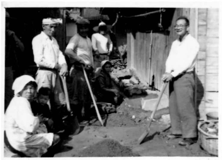
사진 2 하수구 공사의 한 장면
