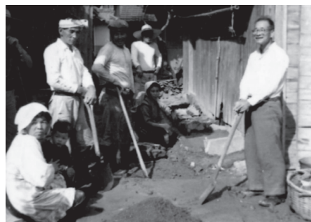
照片2 清理下水道的场景
